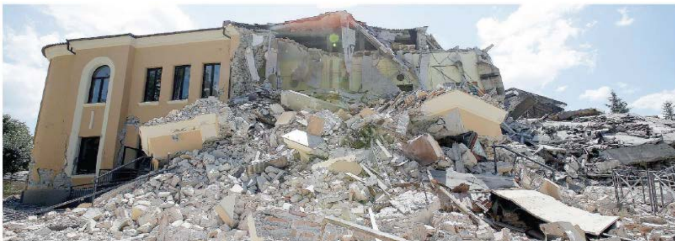
La scuola di Amatrice, un simbolo del terremoto: l'edificio è stato ristrutturato di recente ma è crollato in parte
